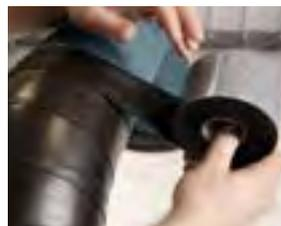
enrolado em volta do tubo isolado com uma sobreposição de 20 mm. O material auto
