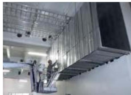
O material de isolamento elastomérico pré-revestido foi especificado para isolar todas as tubagens e condutas do sistema de tratamento de ar. Foram instalados 10.455 m<sup>2</sup> de pranchas em rolo Arma-Chek Silver com espessuras de isolamento de 19, 25 e 32 mm.
