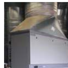
Exemplo de uma instalação de condutas
