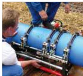
El dispositivo de retro facilita el desmontaje rápido del elemento calefactor
