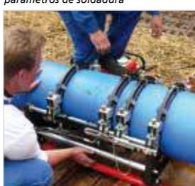
El dispositivo de retiro facilita el desmontaje rápido del elemento calefactor.
